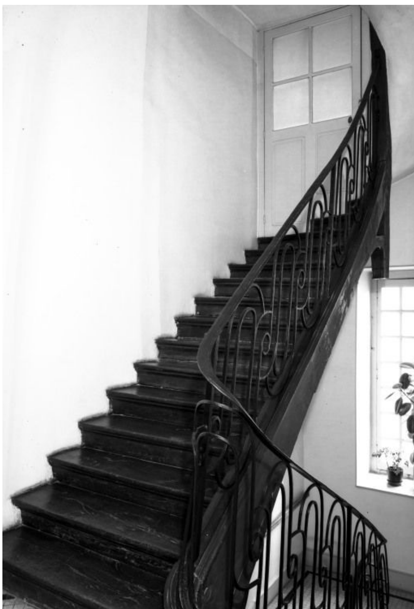
Escalier, volée menant au comble.
