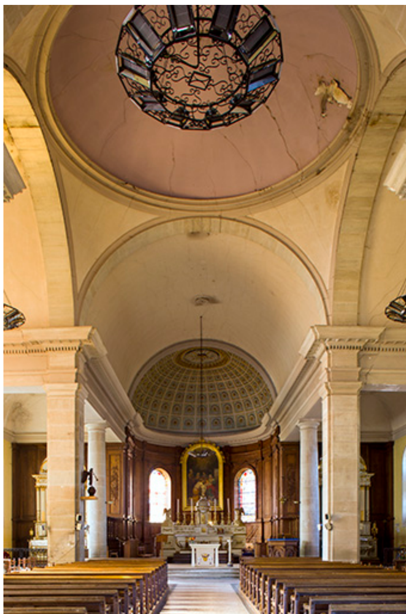
Vue générale de l'intérieur de l'édifice.
