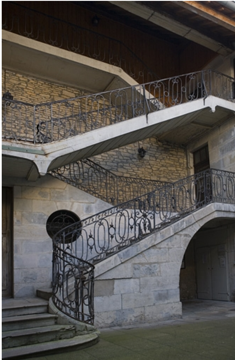
Vue d'ensemble de l'escalier à cage ouverte sur cour.
