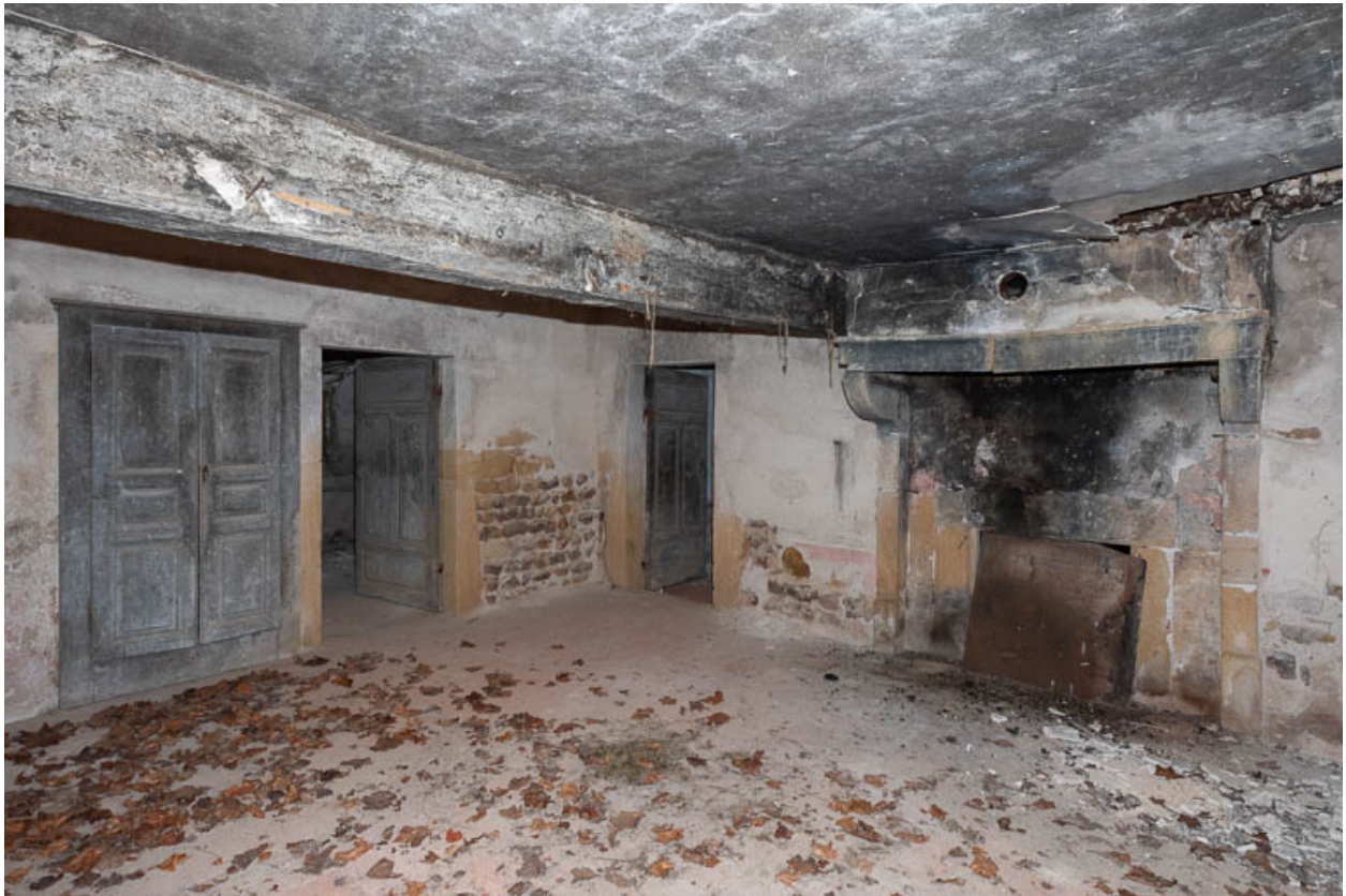
Vue de la pièce principale (cuisine) de l'ancienne maison
