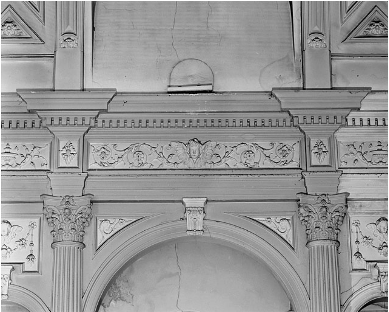
Détail de la partie supérieure d'une travée large de la tribune.
