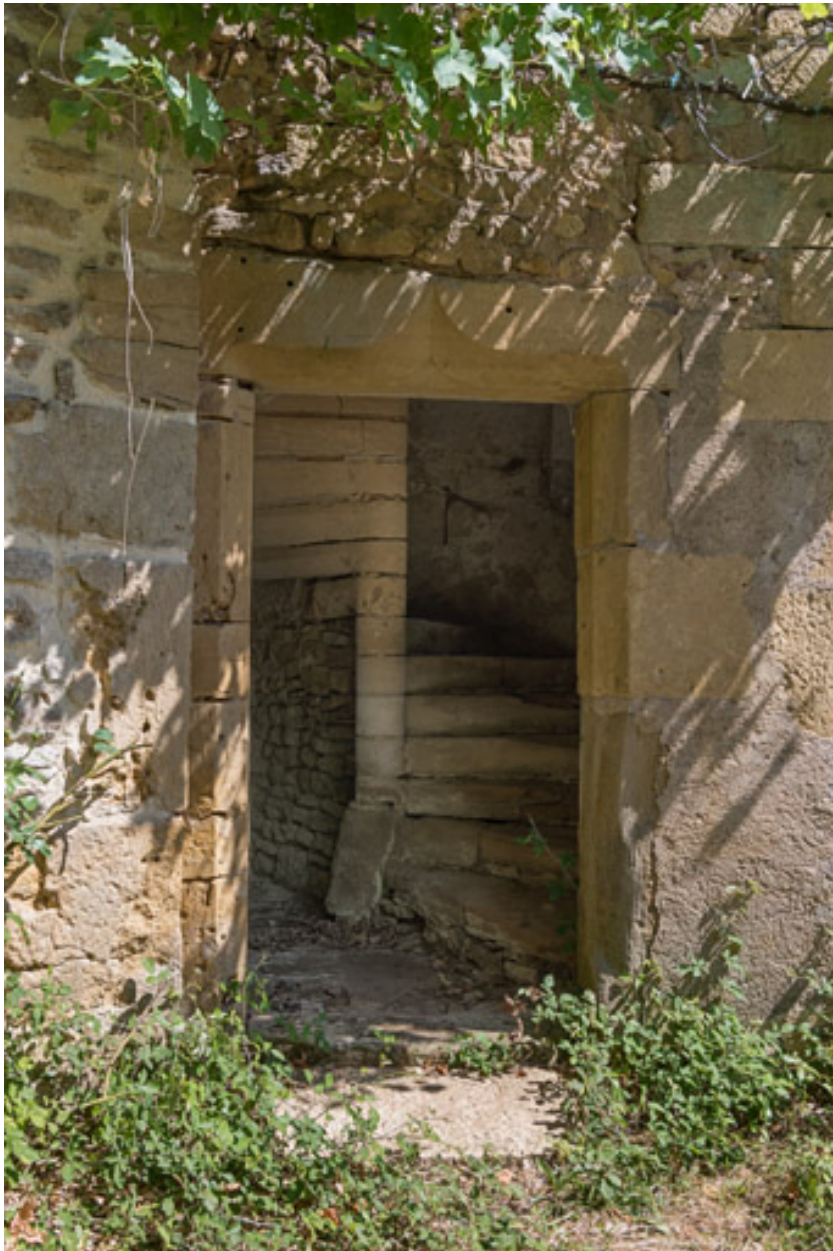
Vue de l'escalier à vis et de sa porte d'accès, avec son linteau orné d'une accolade
