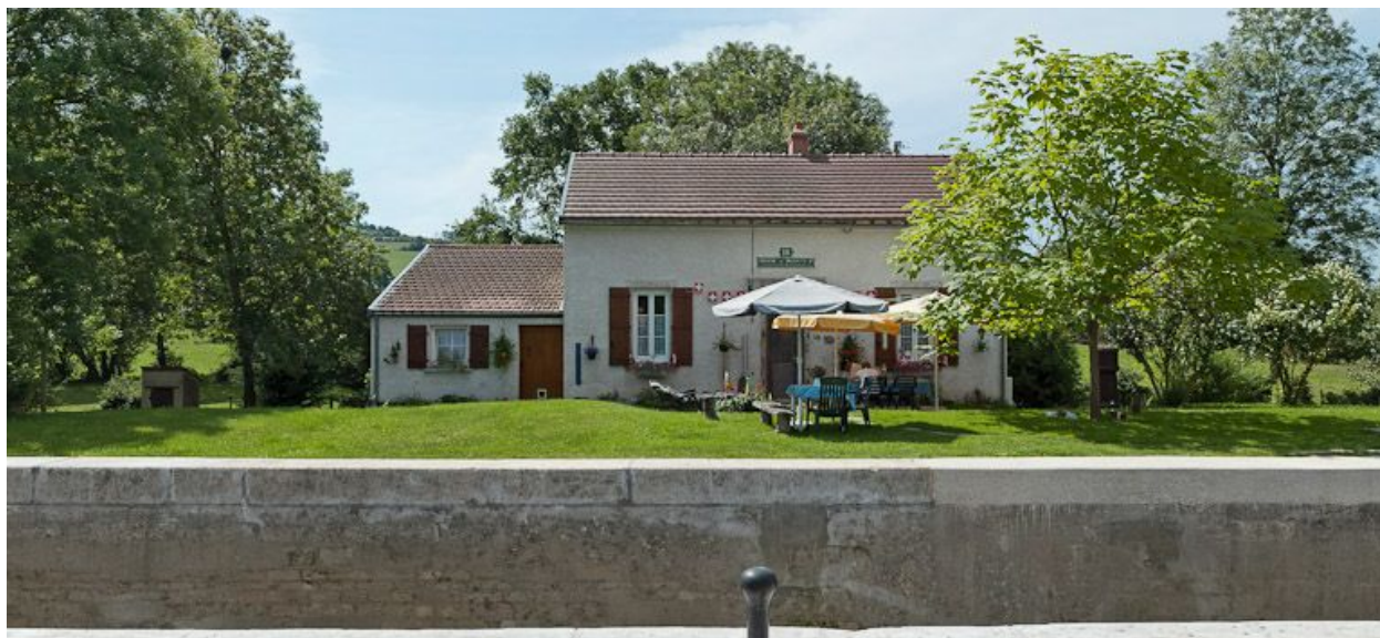
Vue de face de la maison éclusière.
