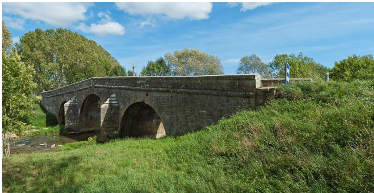
Vue du pont.
