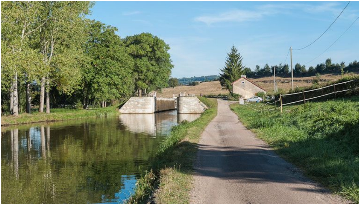
Vue du sas d'écluse depuis l'aval.
