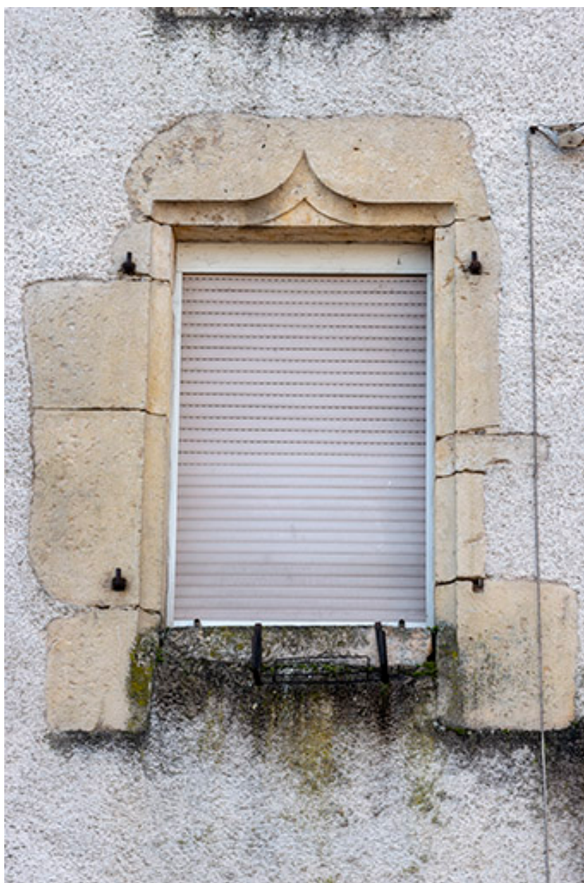
Fenêtre avec linteau en accolade.
