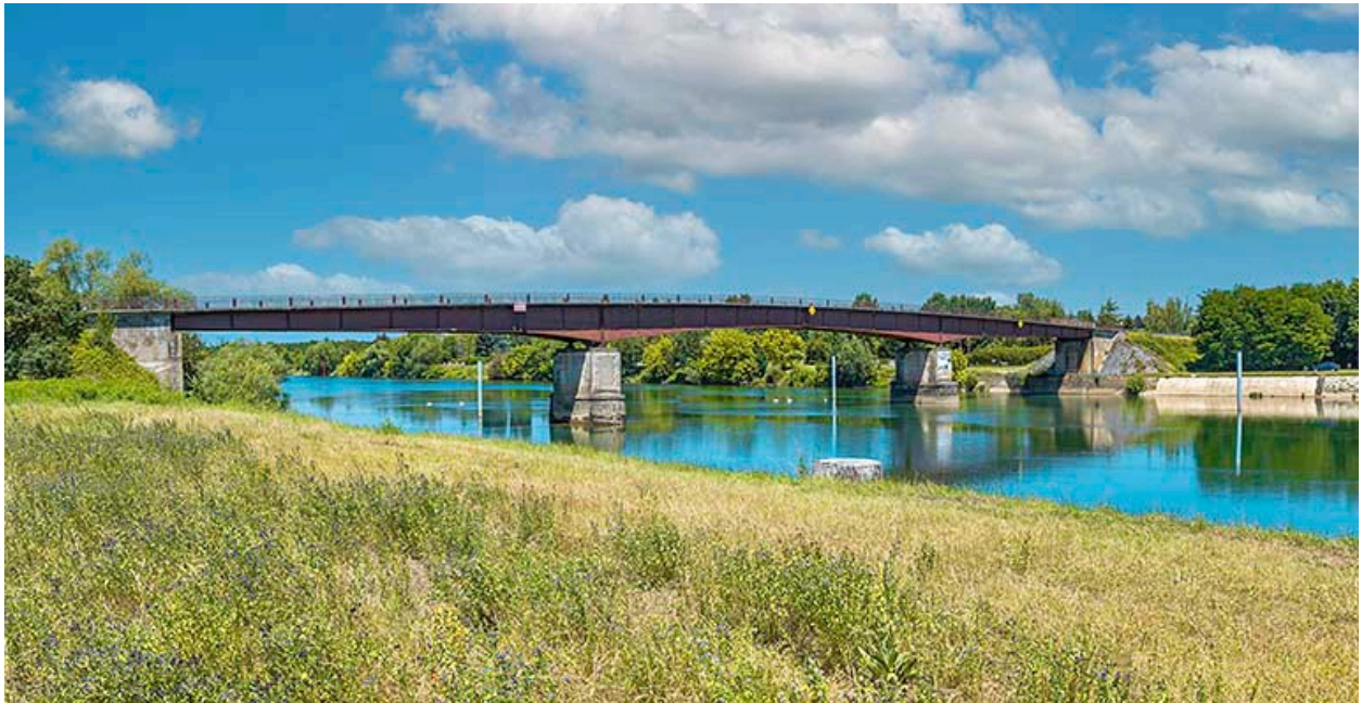
Vue d'ensemble du pont de Bragny.
