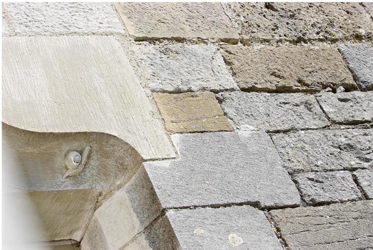
Fenêtre du mur sud surmontée d'une accolade sculptée d'un escargot : détail du gastéropode.
