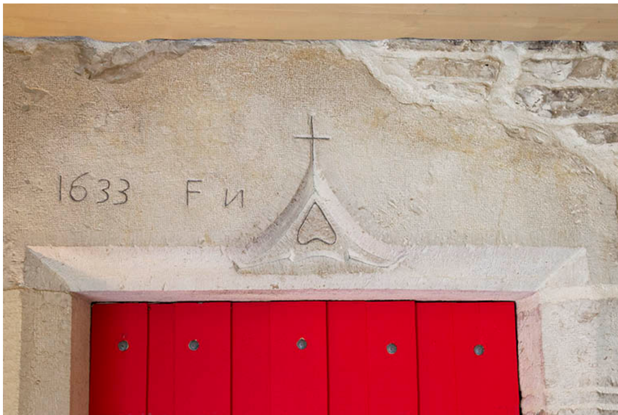
Linteau portant la date 1633, intégré au bâtiment.
