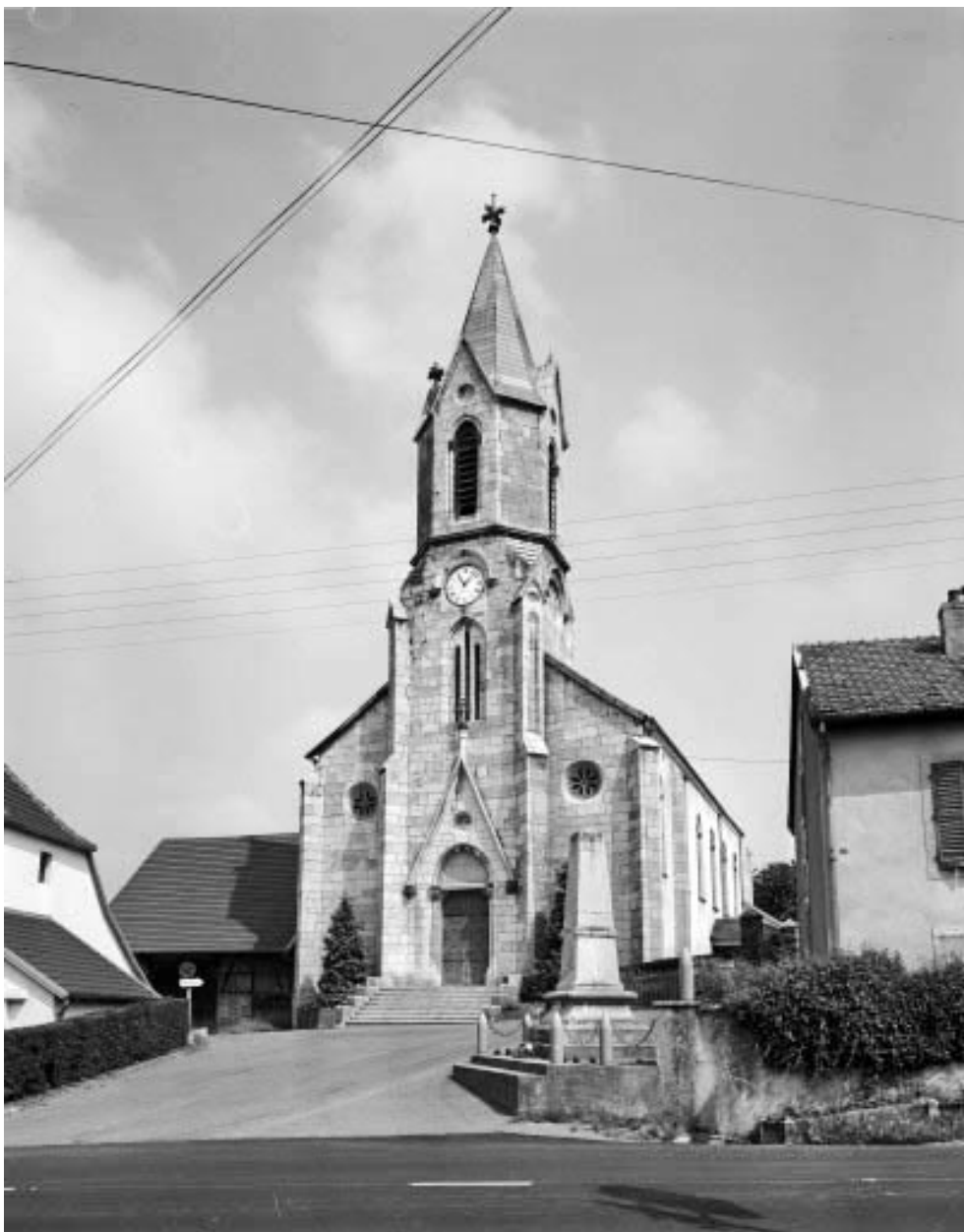
Façade antérieure au Sud.
