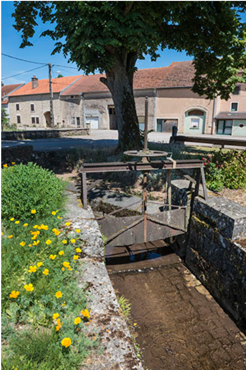
Vanne située à l'extrémité sud du village.
