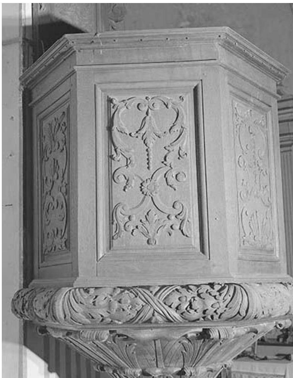
Cuve : deuxième panneau.
