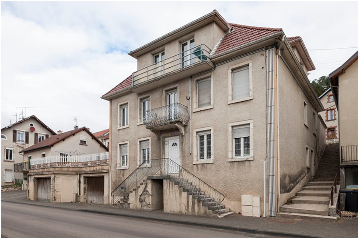
Maison : façades antérieure et latérale droite.
