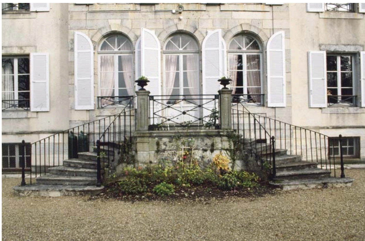
Détail de la façade ouest.
