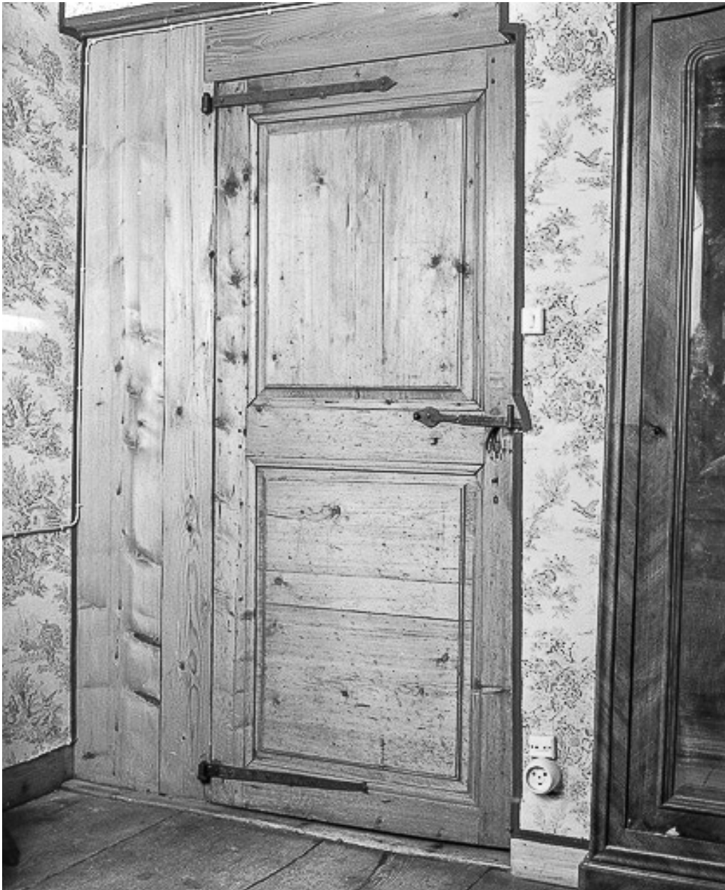
Intérieur en 1977 : porte en résineux.
