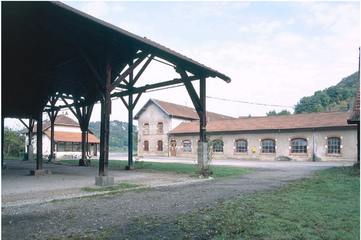
Façade antérieure depuis l'entrepôt à merisier.
