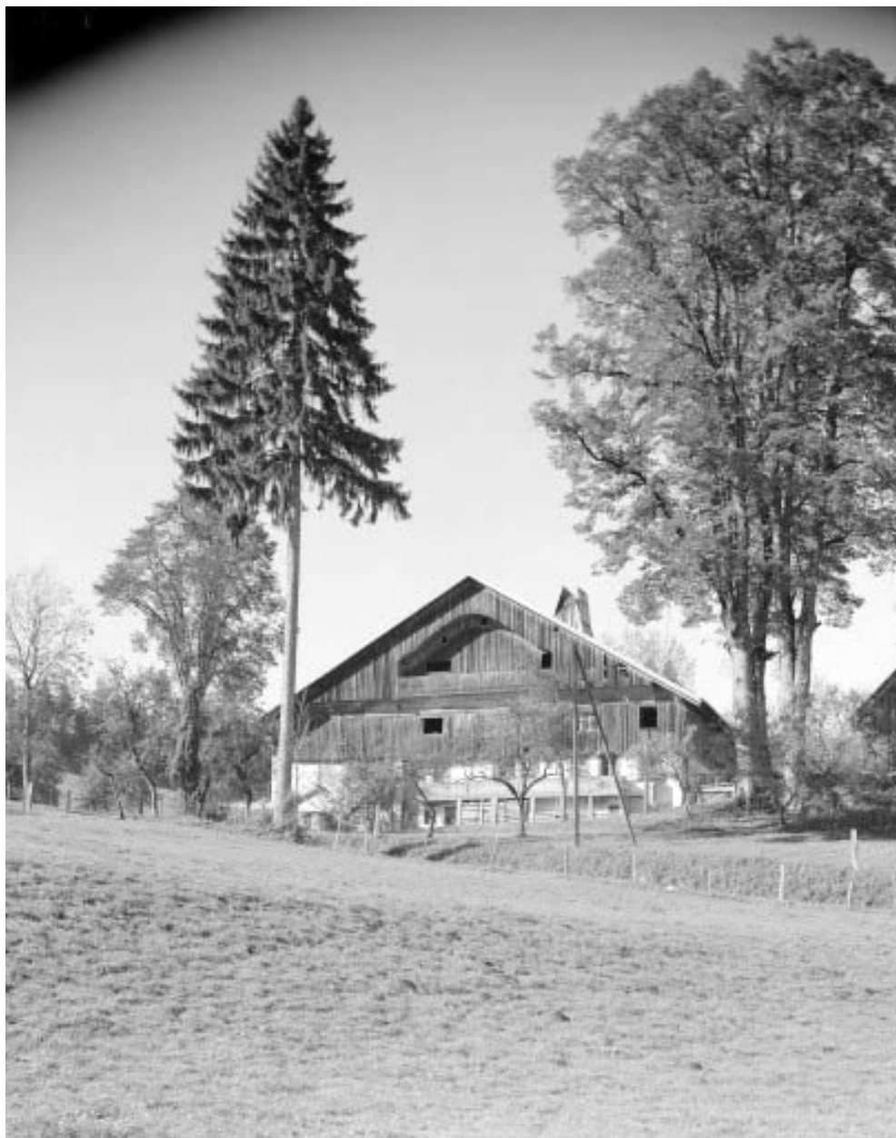
Grand'Combe-Châteleu : ferme 4 située au lieu-dit Cornabey
