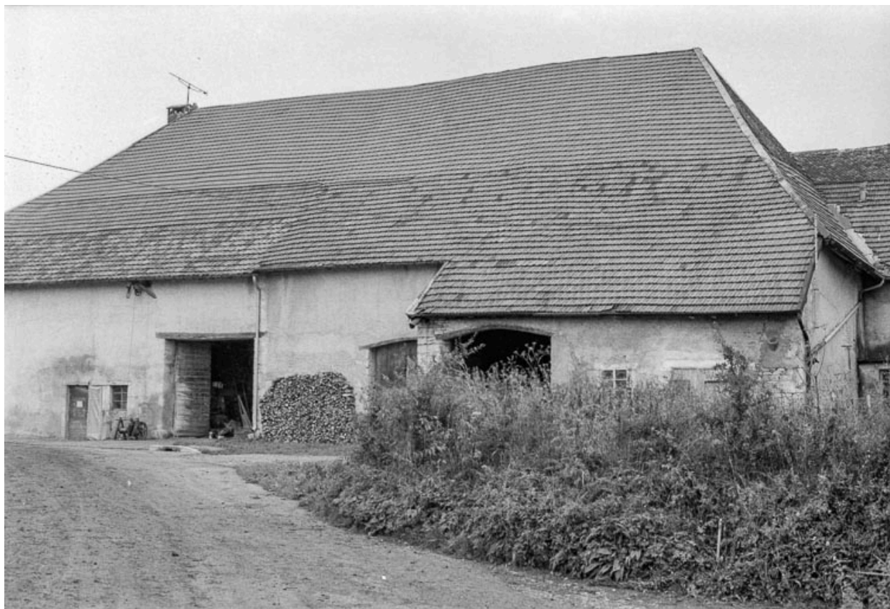
Ferme cadastrée 1939 F 2-3 : façade latérale droite.
