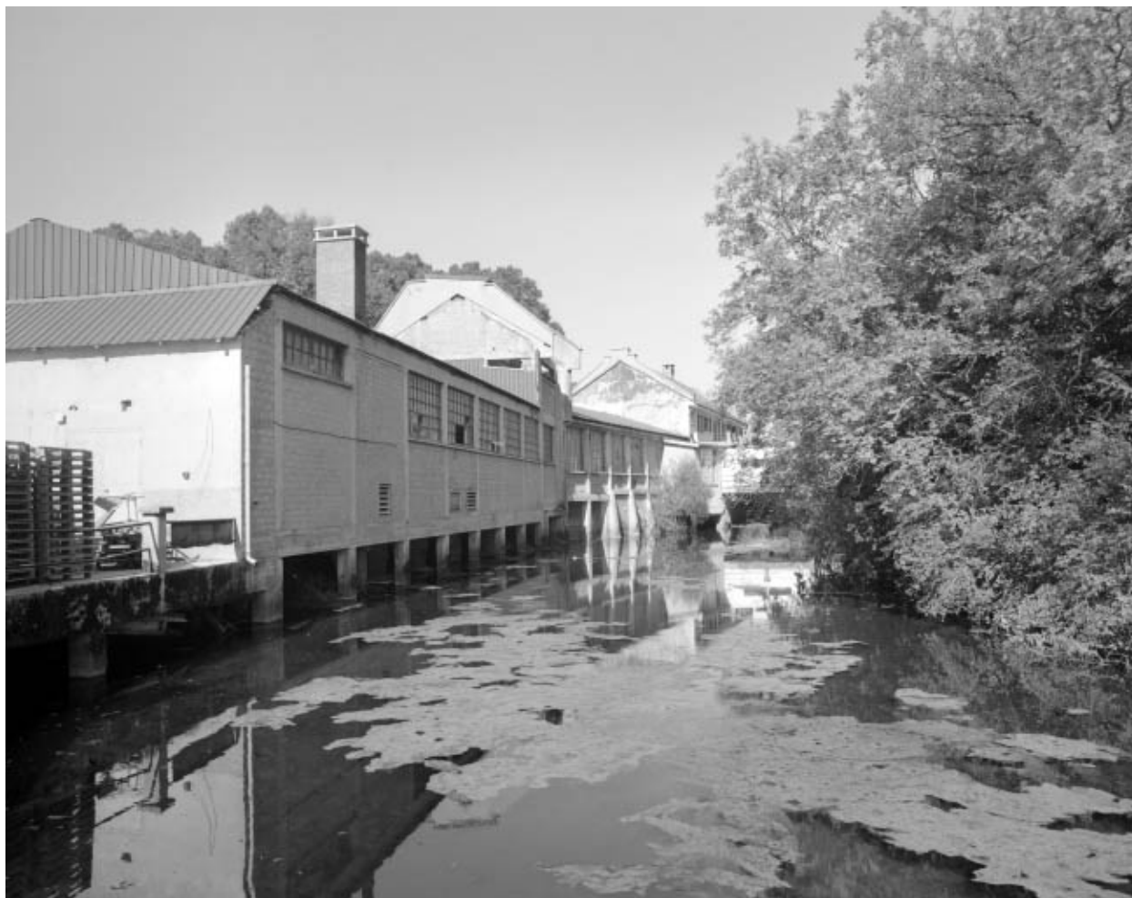
Façades des ateliers de fabrication sur l'Angillon.
