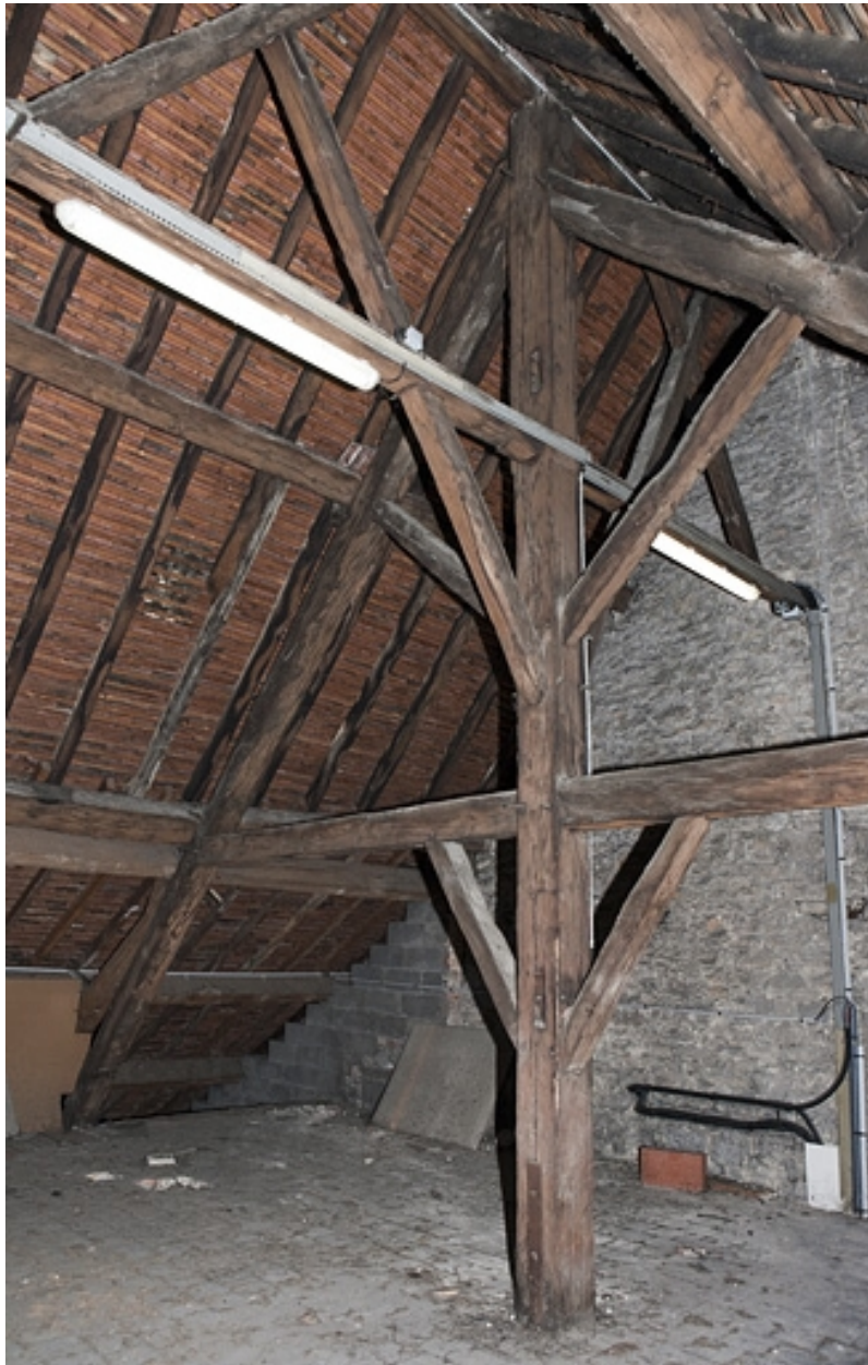
Intérieur, comble : détail de la charpente.
