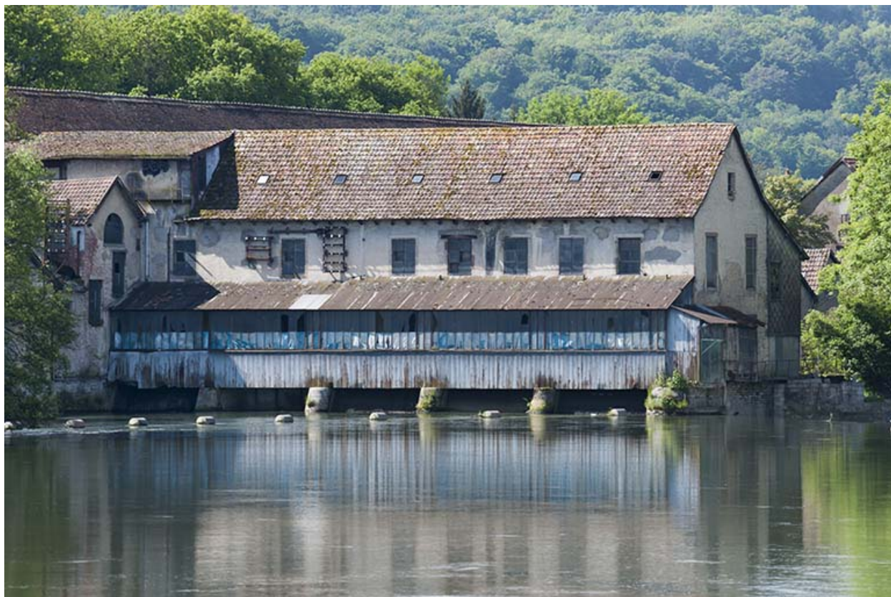
Vue rapprochée du bâtiment d'eau (centrale hydroélectrique).
