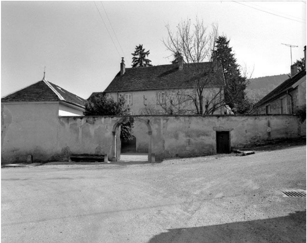
Maison de vigneron située rue Lacuzon.
