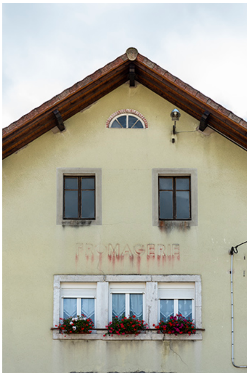
Façade antérieure : travées centrales.
