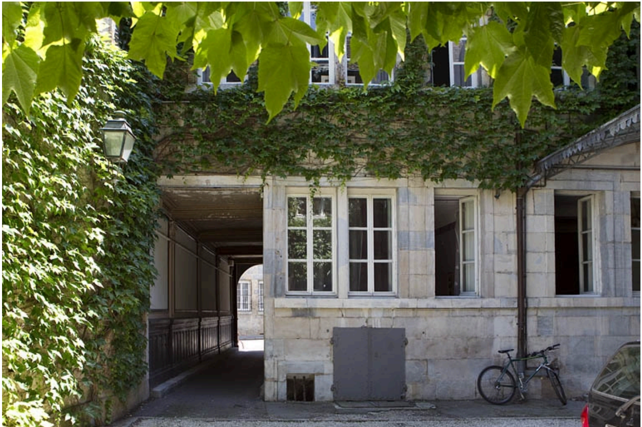
Façade postérieure du logis principal : détail du rez-de-chaussée.
