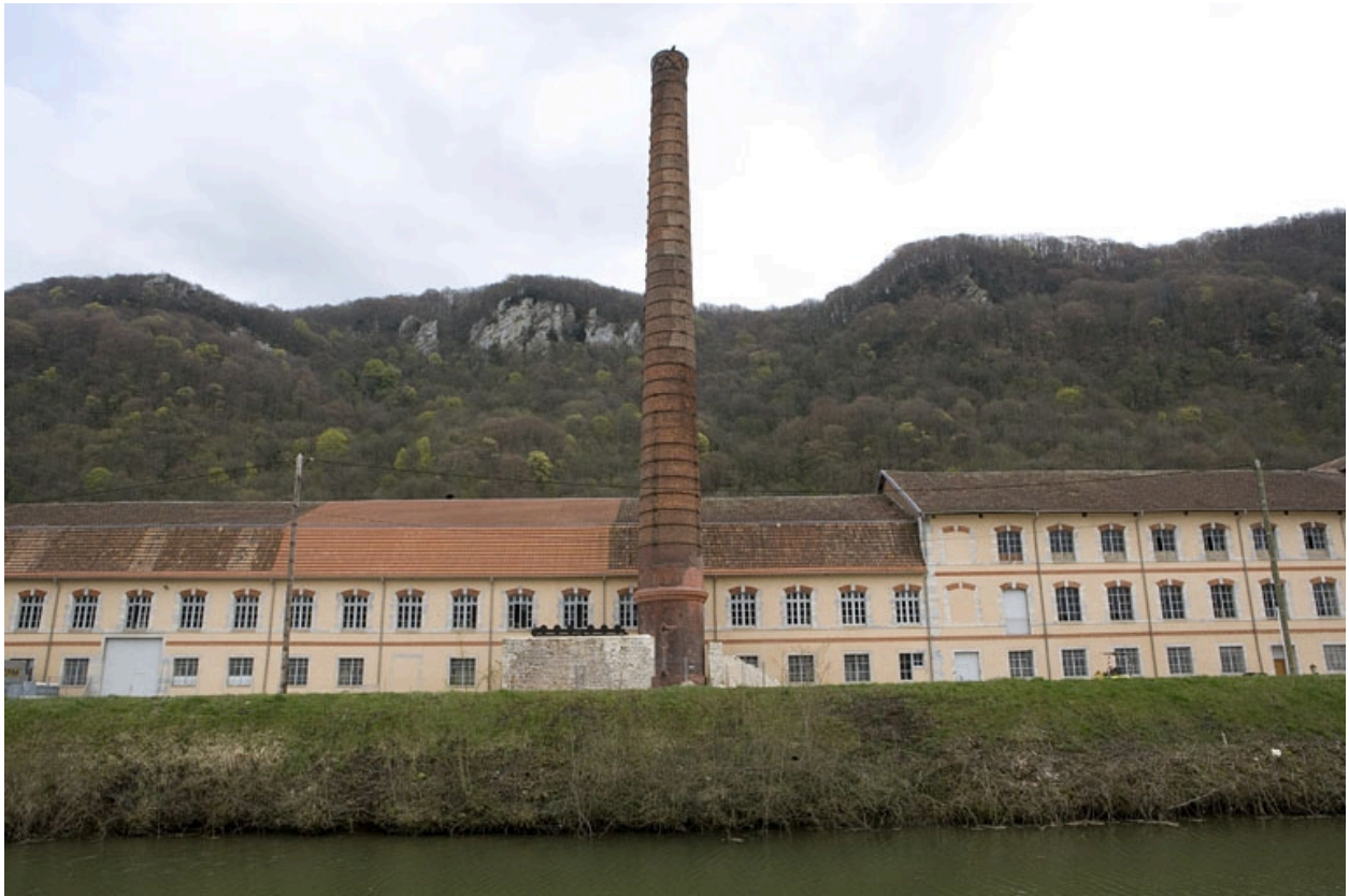
Façade ouest des ateliers de préparation de la pâte et cheminée.
