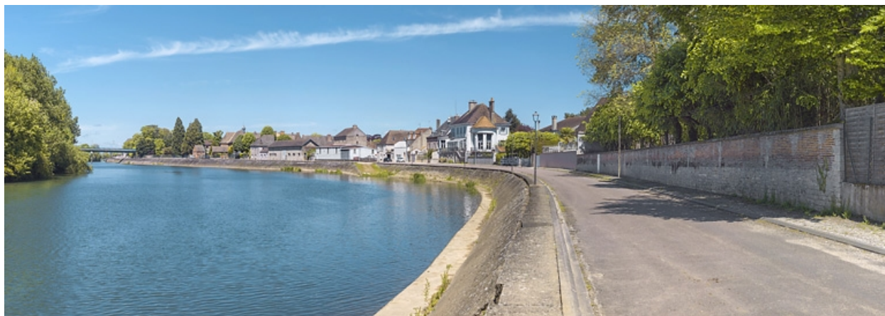
Panorama des quais en aval du pont.
