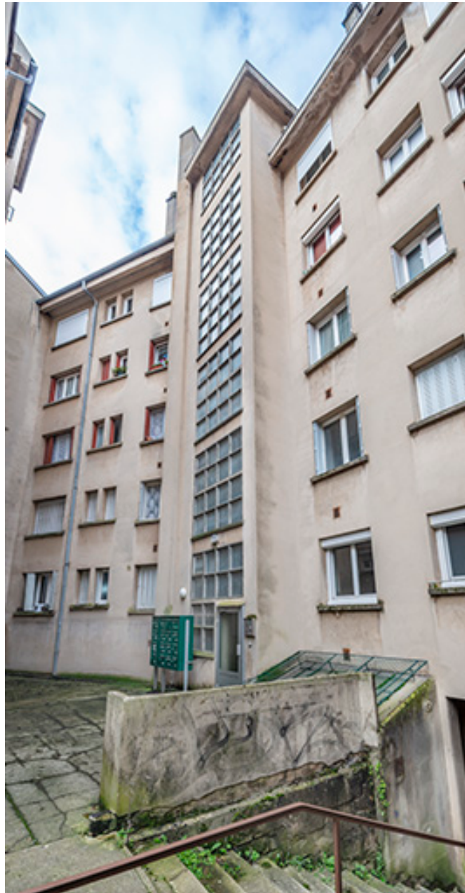
Elévation de la façade est, depuis l'escalier d'Arion.
