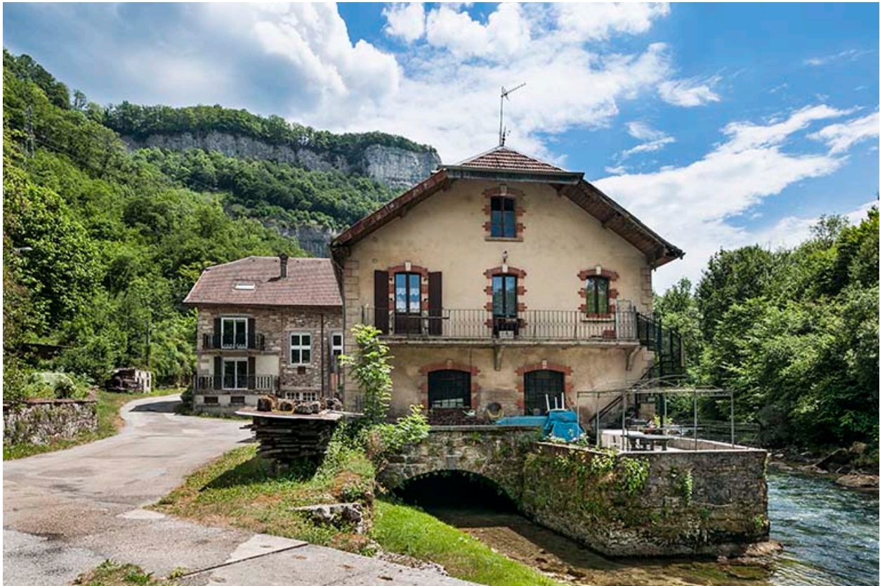
Vue rapprochée depuis l'ouest en 2015.
