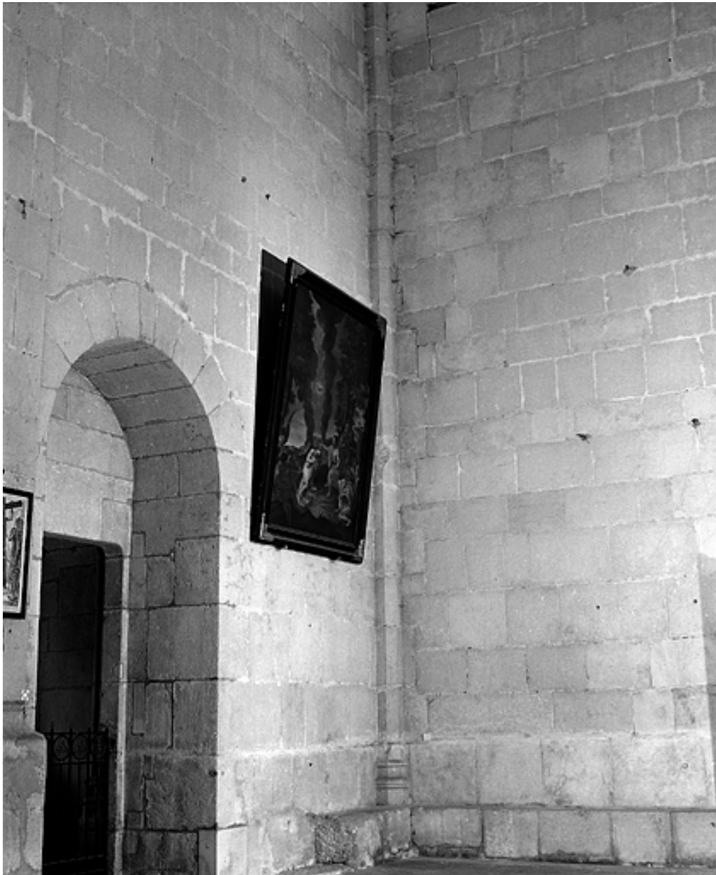
Détail du parement du revers de la façade à l'angle sud-ouest.
