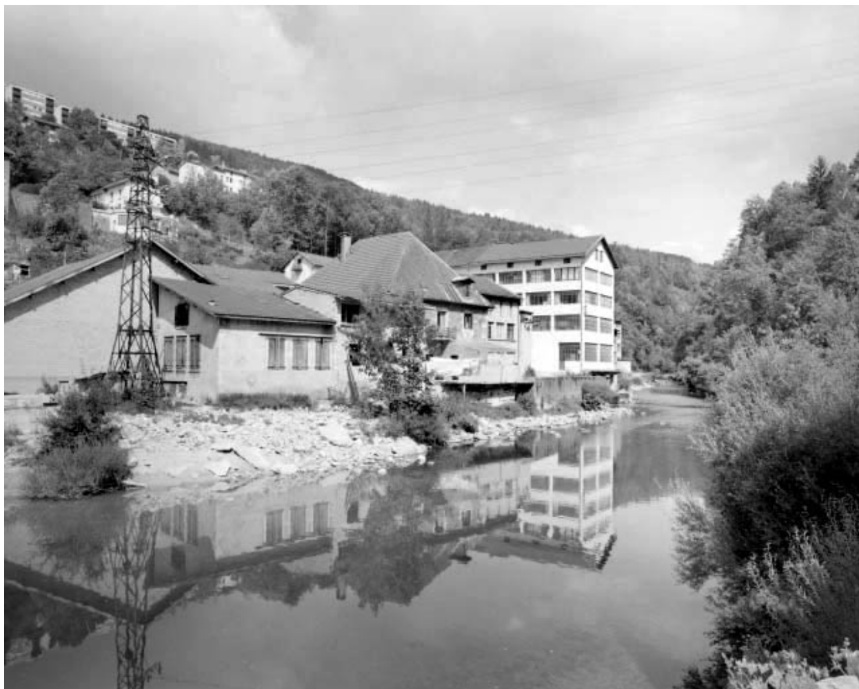
Façade postérieure des bâtiments, depuis l'aval.
