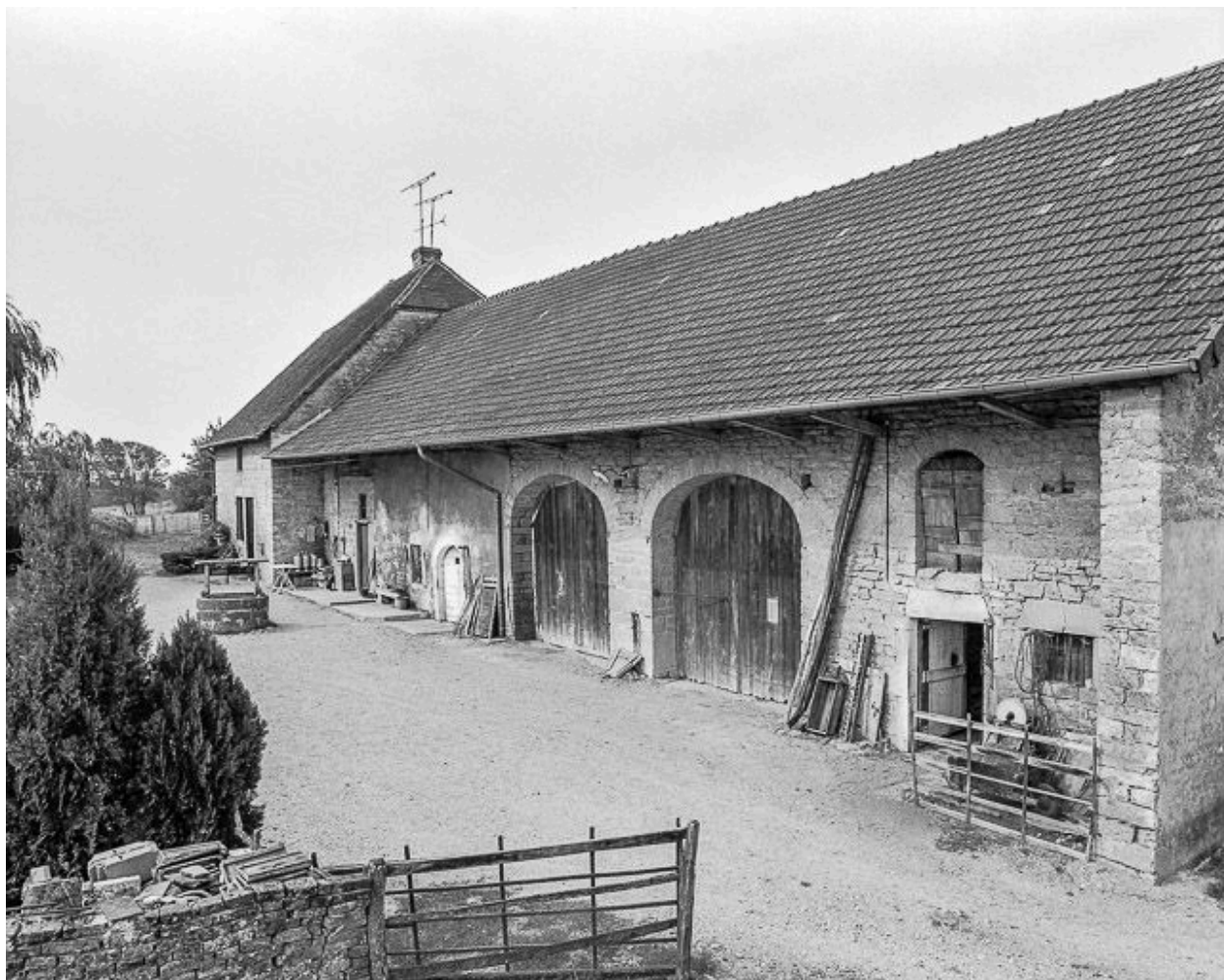
Le bâtiment à droite de la cour.
