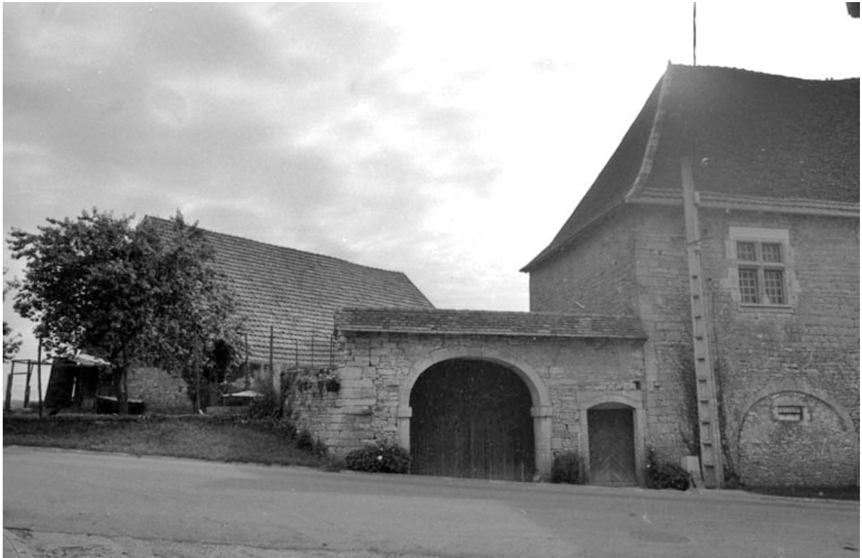
Portail d'entrée et bâtiment agricole.
