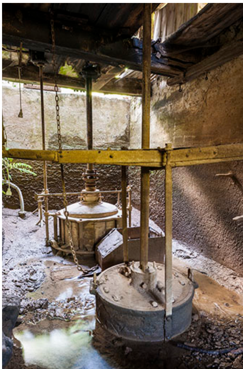
La chambre d'eau des turbines.
