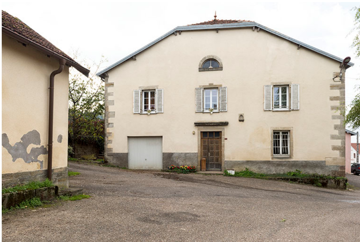
Vue de face : pignon est.
