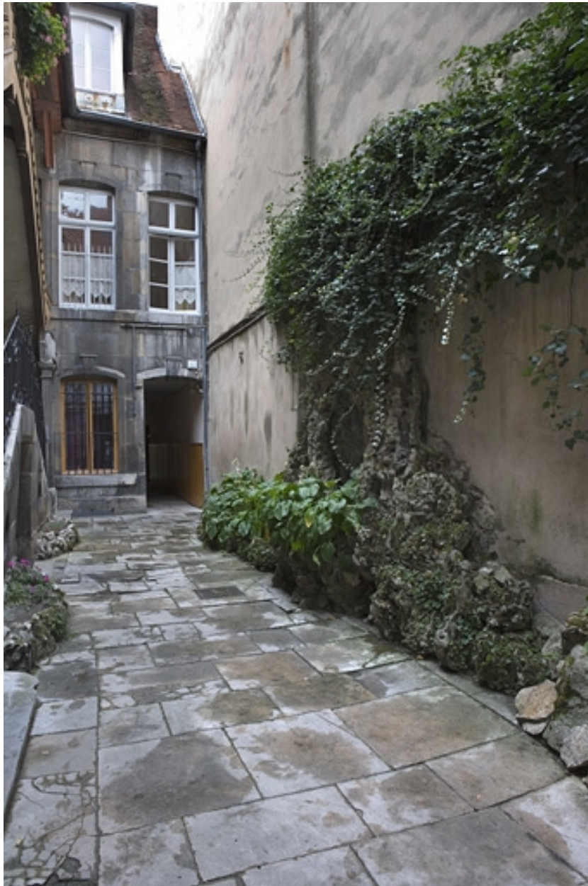
Façade antérieure du logis secondaire sur cour.
