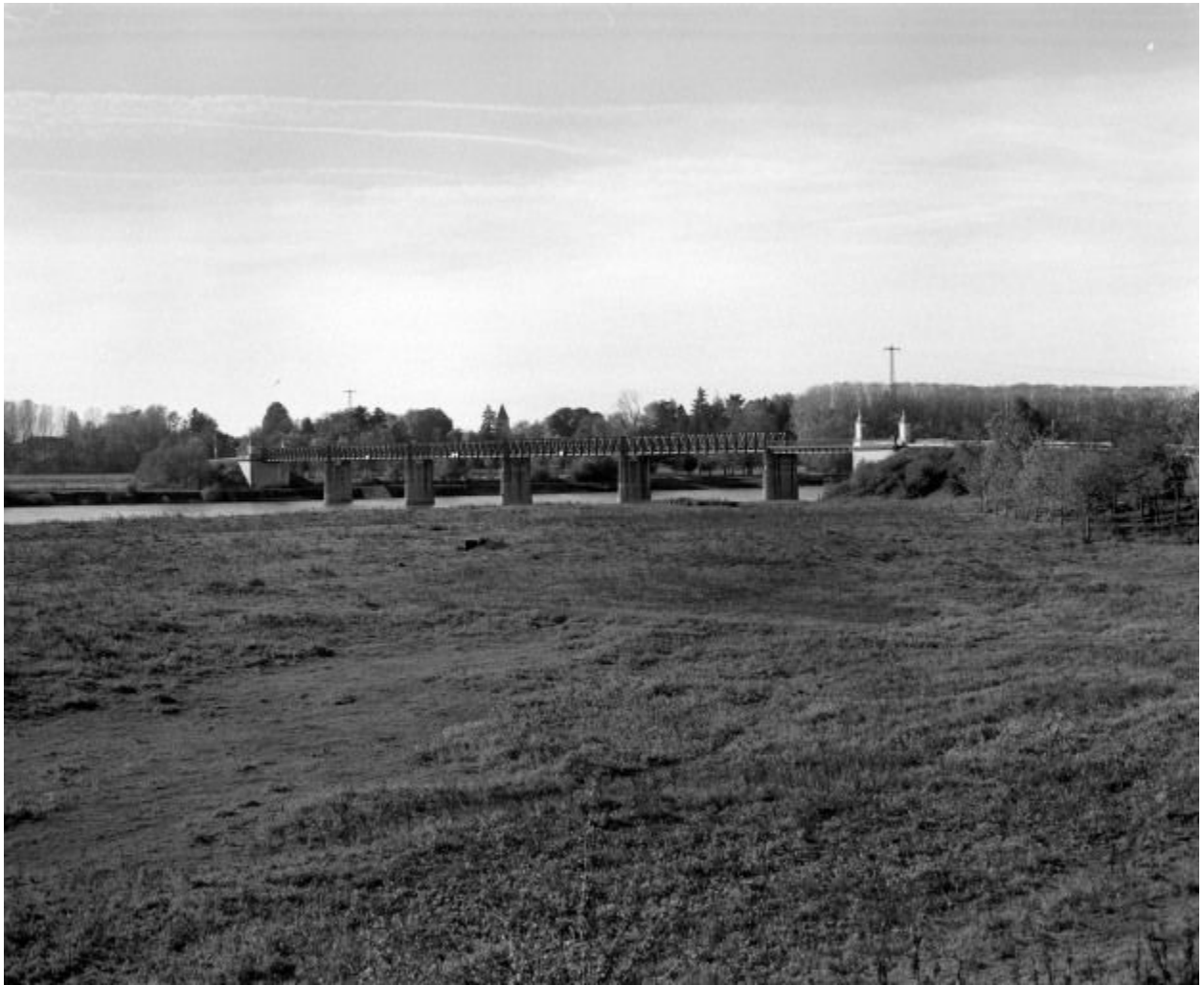
Vue d'ensemble du pont en 1986.
