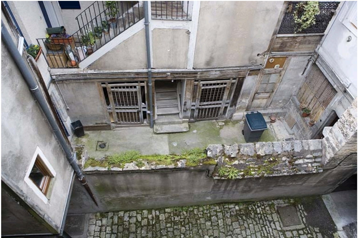
Vue plongeante sur la cour depuis la parcelle voisine.
