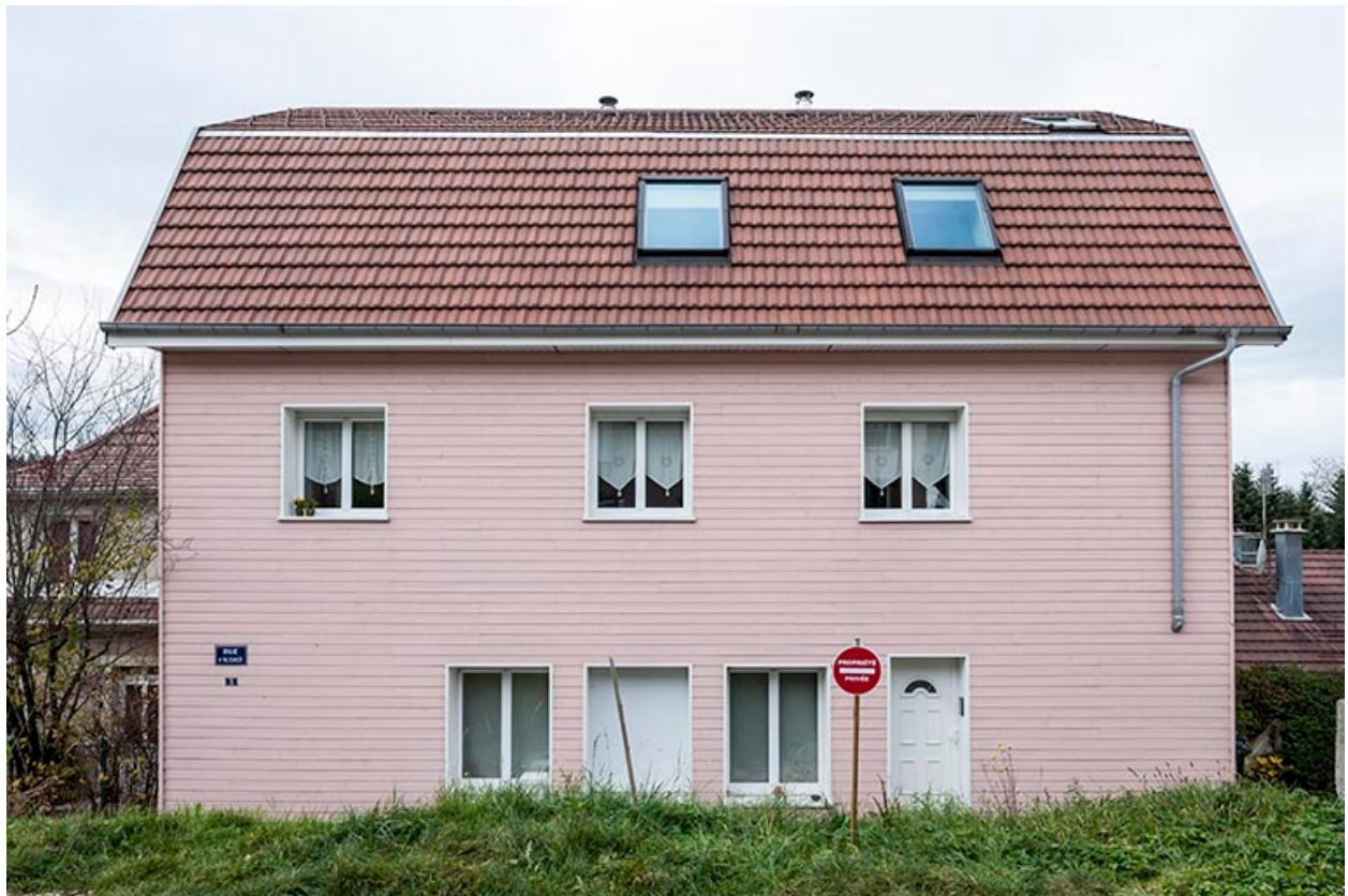
Atelier : façade postérieure.
