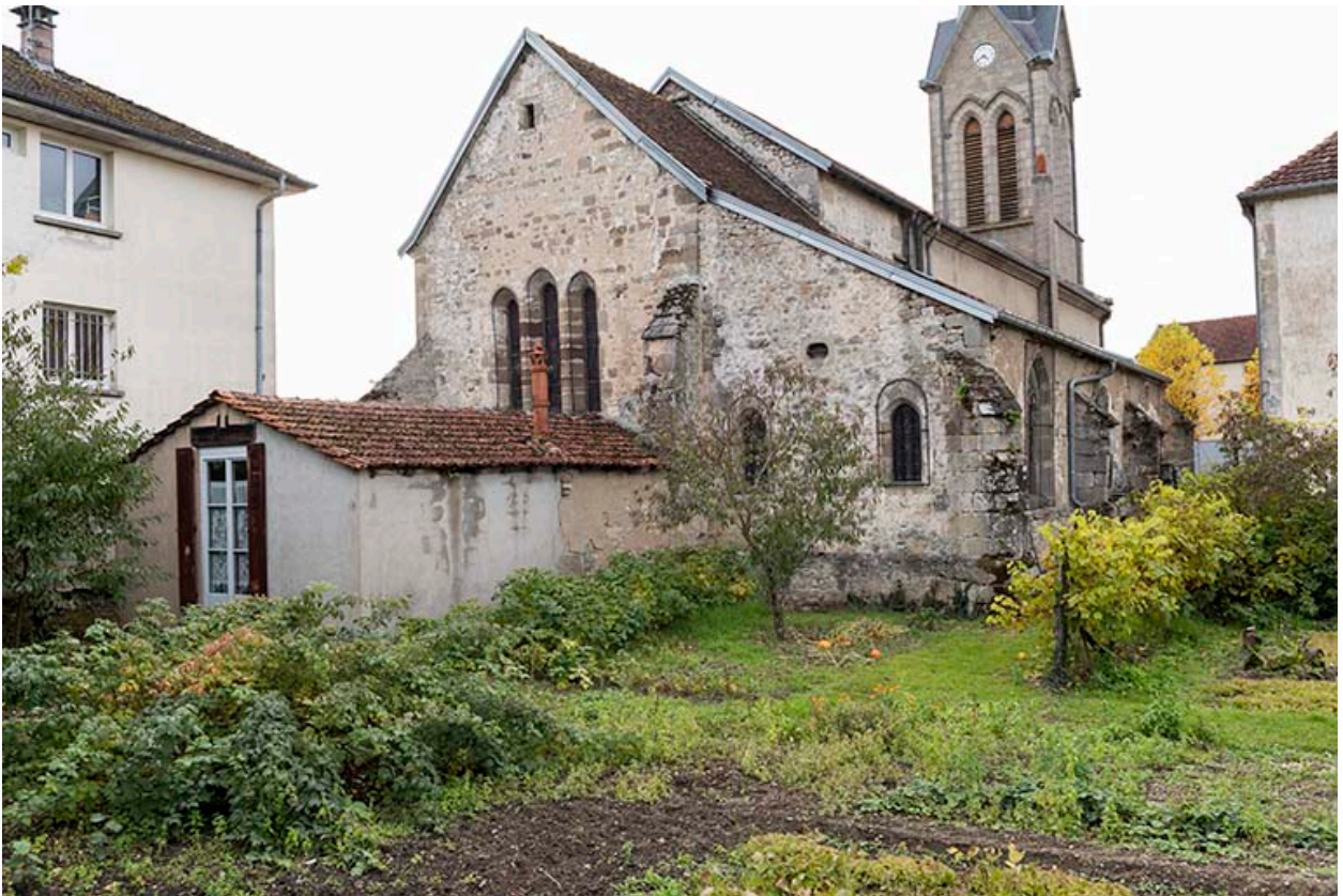
Vue d'ensemble nord-est.
