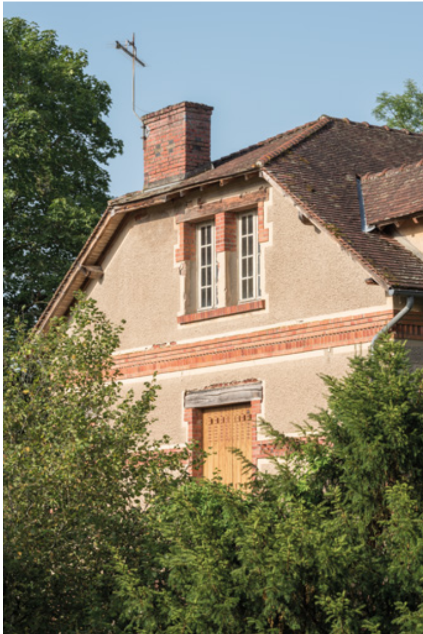
Mur pignon occidental, détail de l'étage de comble.
