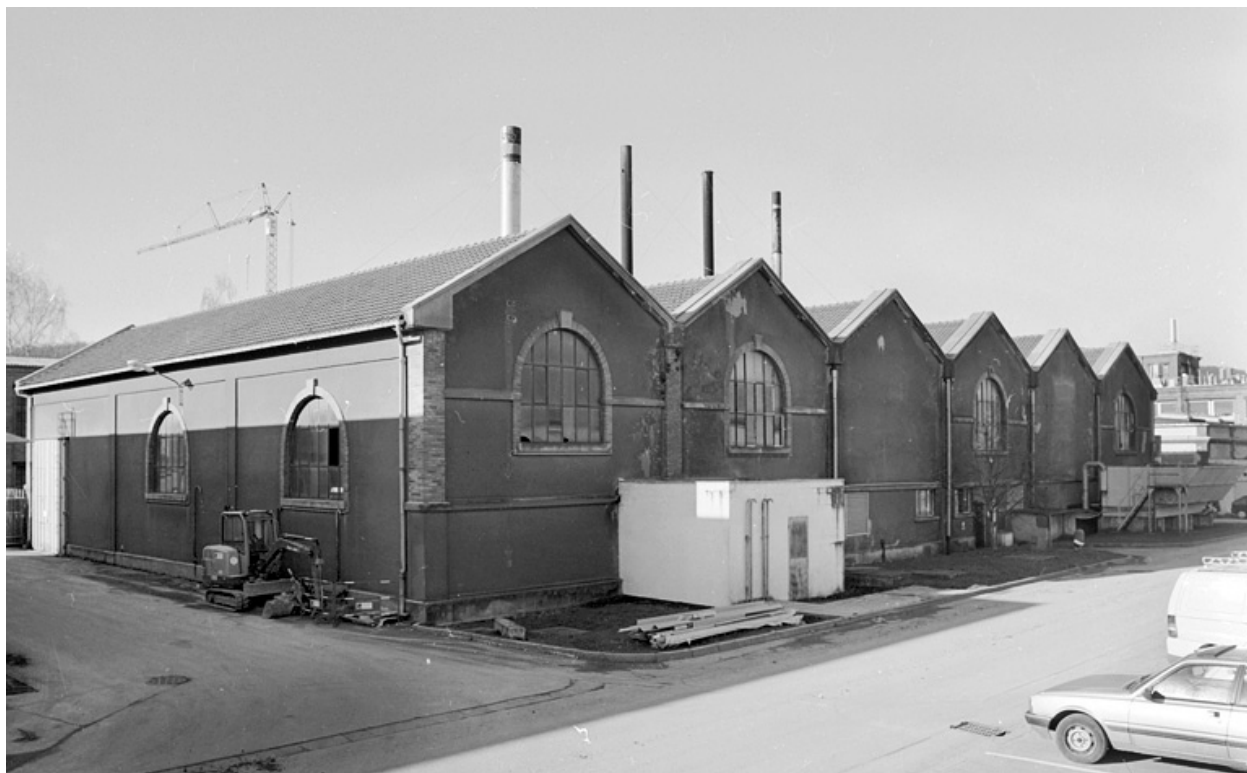
Chaufferie : vue depuis le sud-est.
