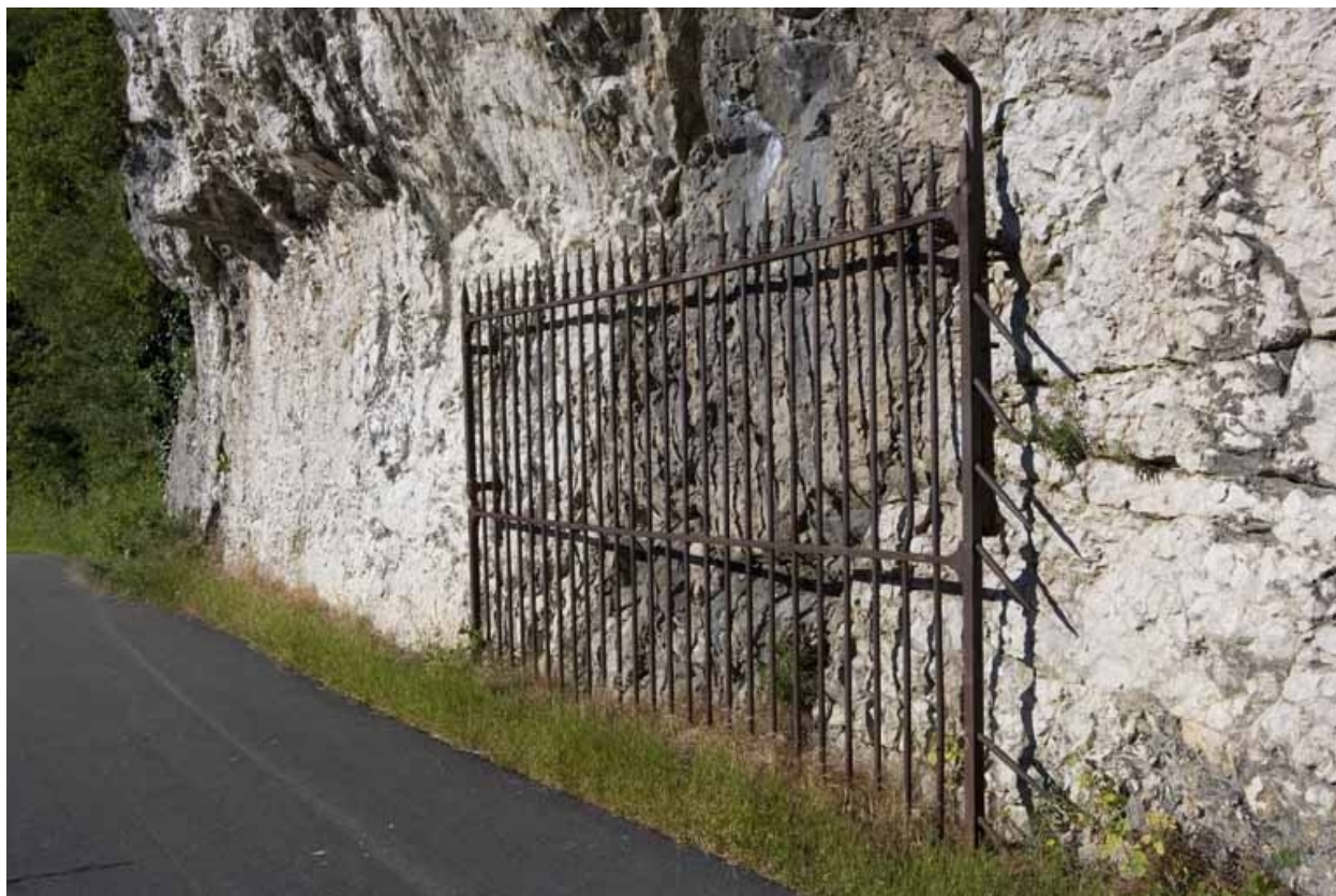
Chemin de halage, rocher et grille.
