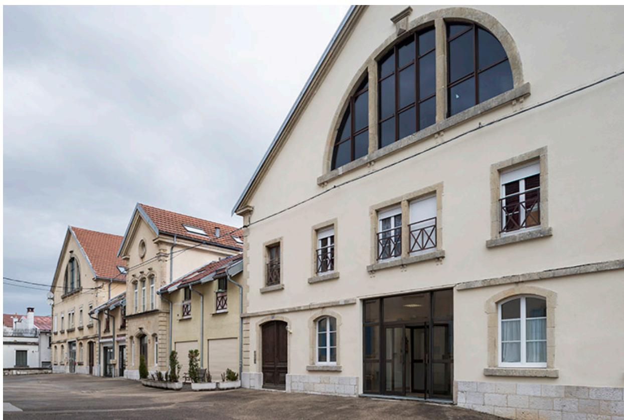
Façade ouest des chais et entrepôts.
