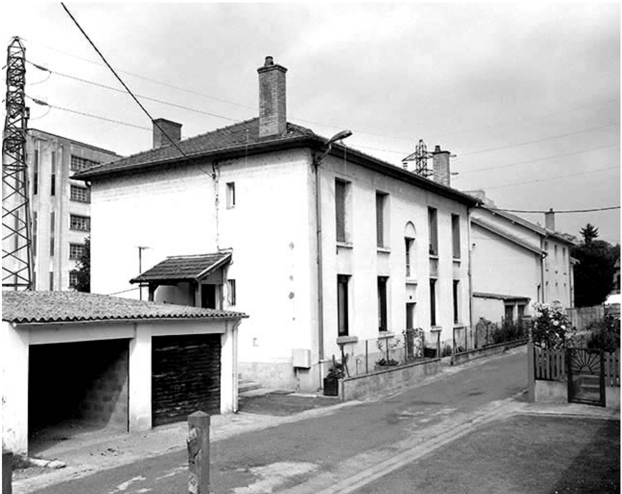
Maison de type IIIb (3, cité Rhodiacéta), vue de trois quarts gauche.
