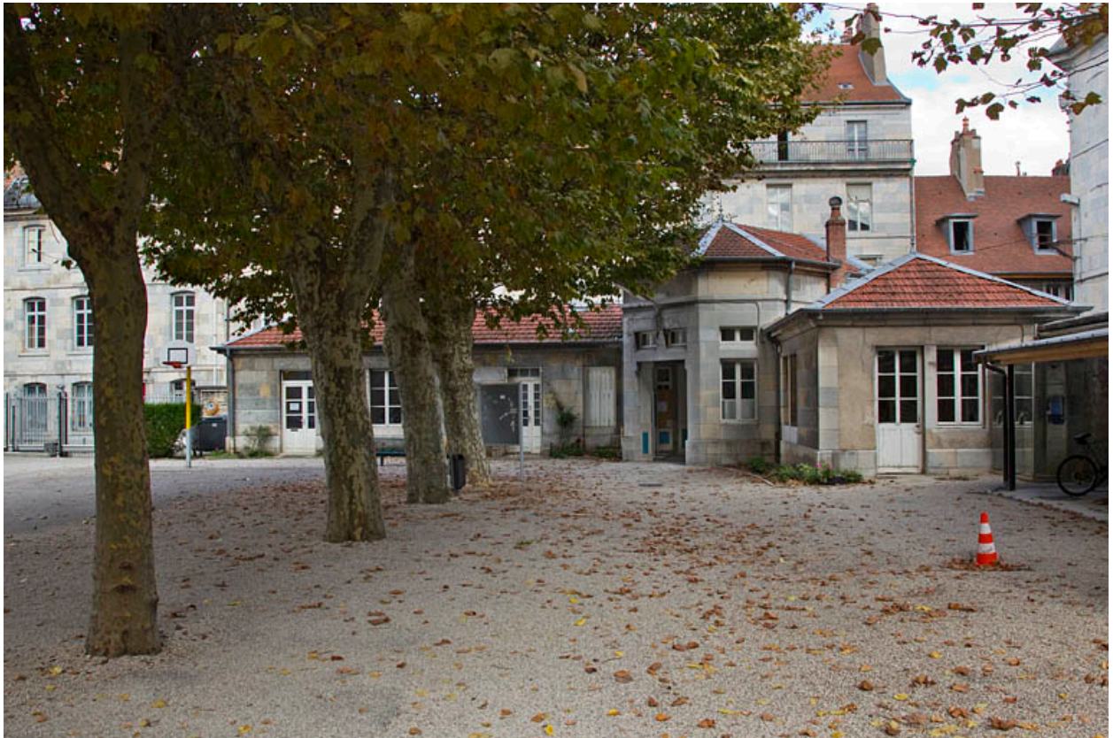
Vue de la loge du lycée formant l'angle des rues du lycée et Girod de Chantrans depuis la cour.
