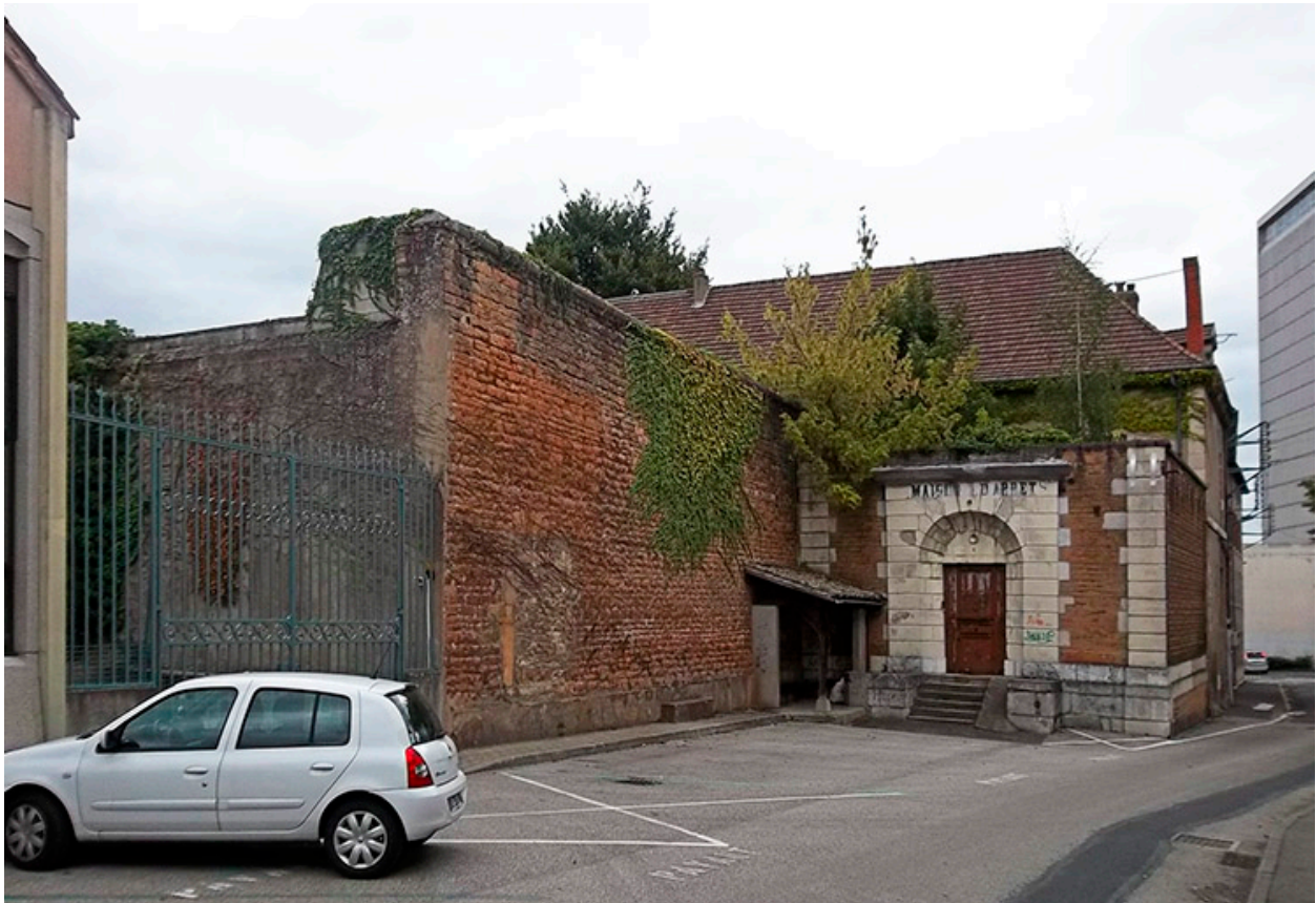
Entrée de la cour de la prison (au fond) et portail menant à la cour nord du palais de justice (à gauche).
